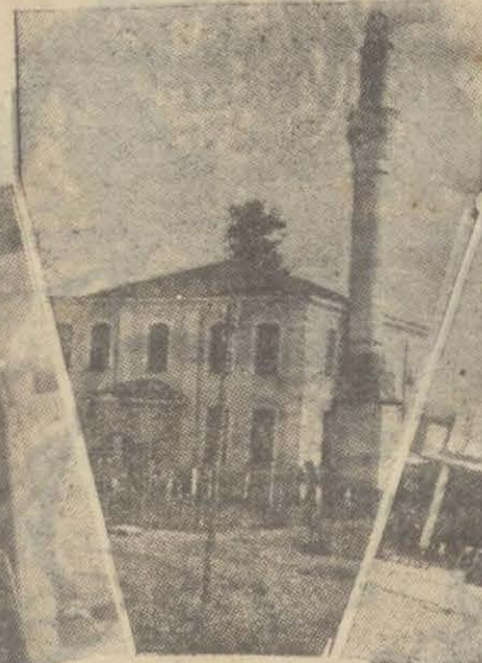
Soğanpazarındaki Evkaf akarı
